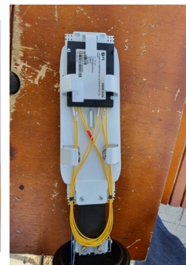
Abertura dos canais para atendimento das unidades (instalação externa)
